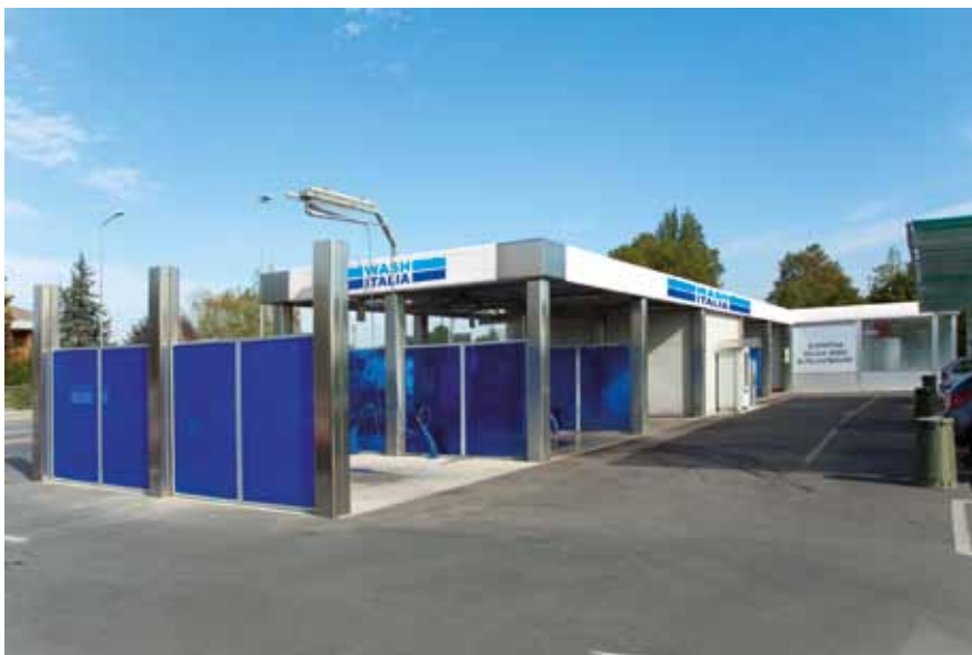
Открытый пост мойки с боковой защитной стеной
