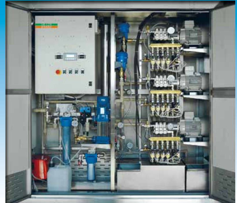
Particolare interno / Detail
